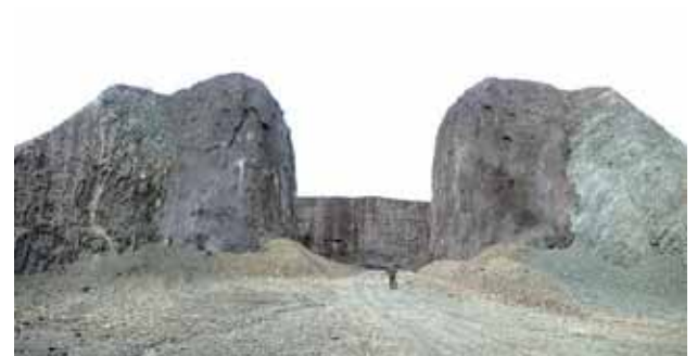
Í biðstöðu Grunnur stöðvarhússins var sprengdur árið 2002.
